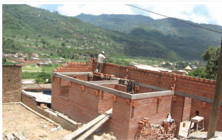
Fotografía 5.3.3 Vivienda en etapa de reconstrucción en el mismo terreno afectado, en el Municipio de Caranavi
