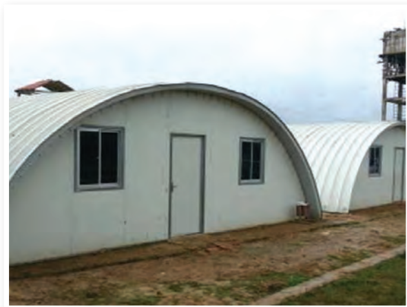
Fotografía 5.1.5 Instalación de módulos a la unidad educativa Villa Marín, Trinidad
